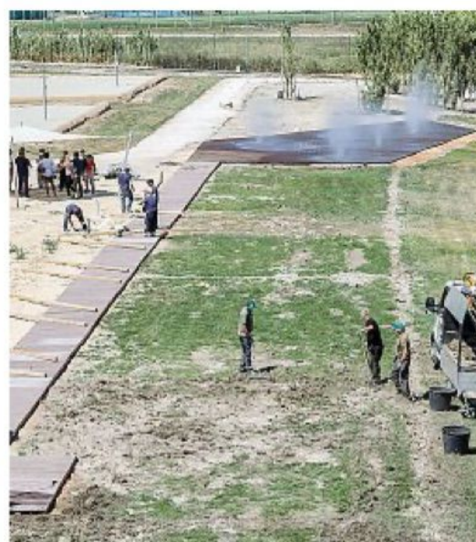
Ponte Marconi Gli operai al lavoro per la realizzazione della spiaggia Tiberis
